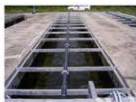
図5. 畜産排水中有機物除去の土壤浸透システム構築
