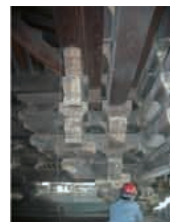
文化財建造物の耐久性調査
