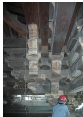
伝統木造の耐久性調査。
